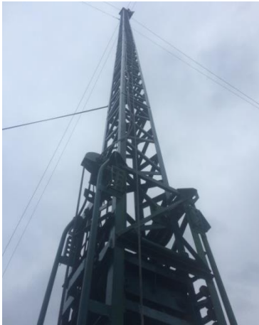
Рис. 6. Мачта анемометра, оборудованная вибродатчиками
